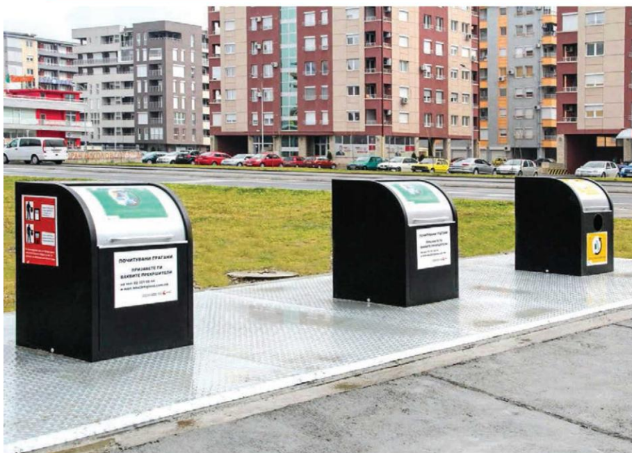
Слика 17. Подземни контејнери
